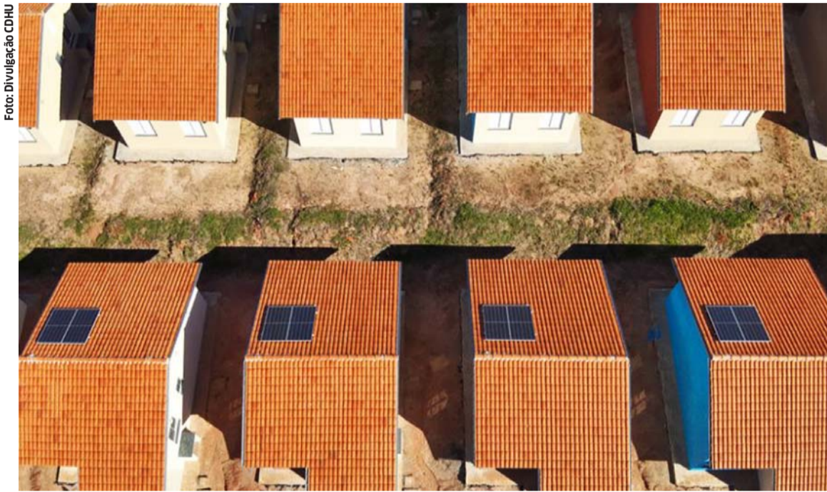
A adoção de tecnologias voltadas à eficiência energética e hídrica faz parte das diretrizes da CDHU para os empreendimentos habitacionais
