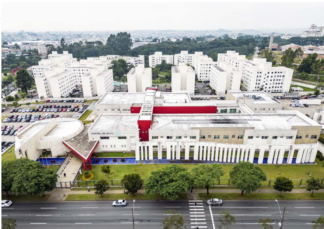
Hospital Municipal do Idoso Zilda Arns, administrado pela Feas, está no bairro Pinheirinho
